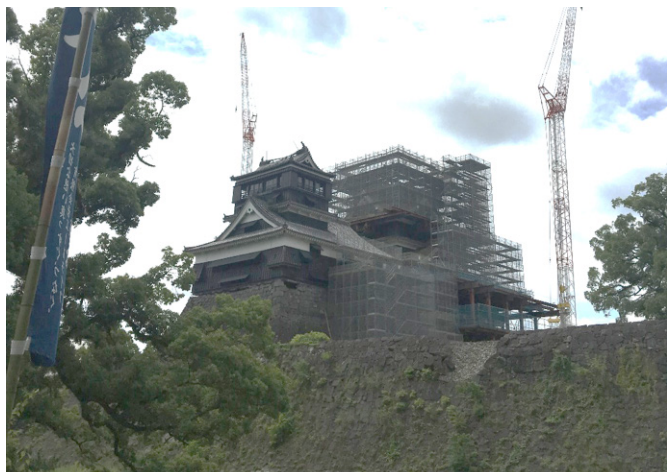
合間に見学した熊本城天守の被災復旧工事の様子
